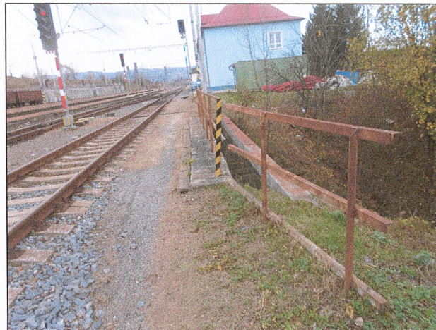
Pohled na „levou“ římsu mostu proti směru kilometráže, nová kabelová lávka se předpokládá vpravo římsy namísto stávajícího žlabu
